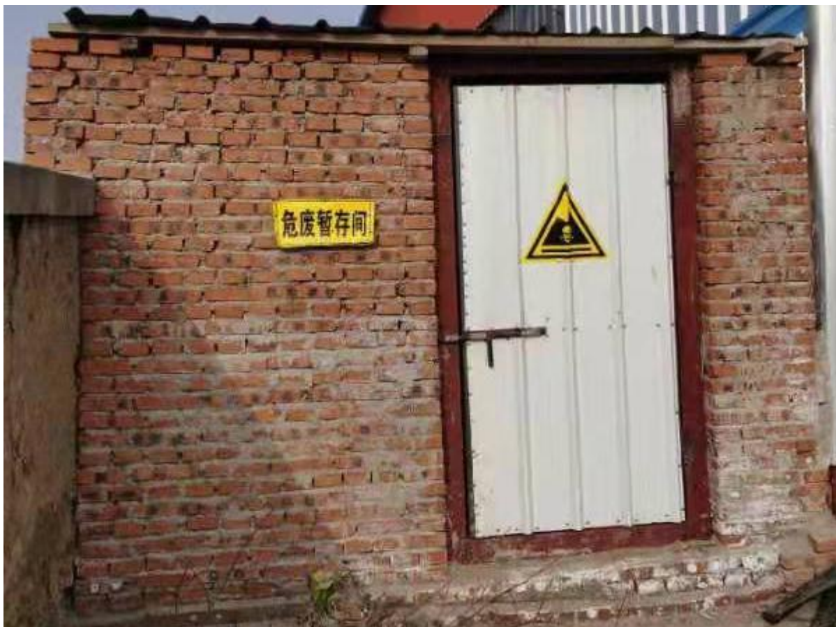
危险废物暂存间
