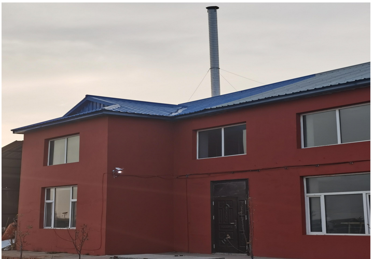
车间废气排气筒
